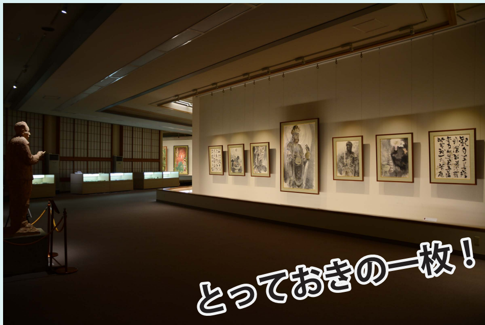
展示室内の照明工事後の様子 平成29年(2017)1月31日頃撮影
